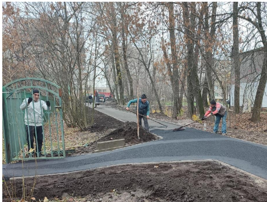
Софийская улица, 26/3, дорожка от станции «Фарфоровский пост»
